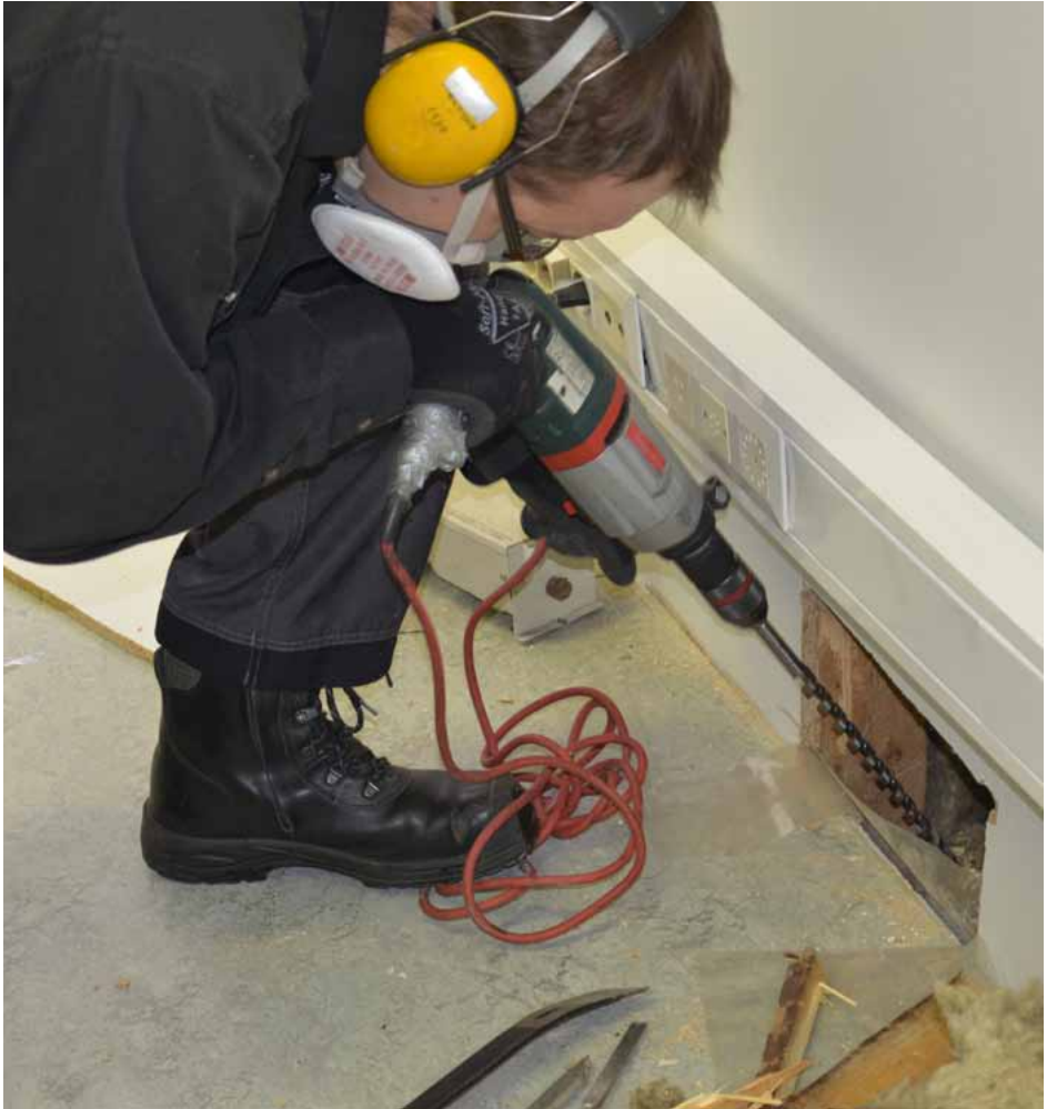
Kosteus- ja homevaurioita tutkittaessa joudutaan usein avaamaan talon rakenteita, jotta vaurio voidaan paikallistaa.
